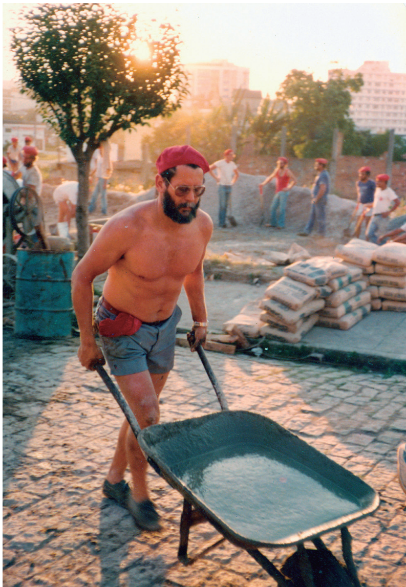
■ MILITANTES DO PT TRABALHAM VOLUNTARIAMENTE NA CONSTRUÇÃO DA SEDE DO DIRETÓRIO MUNICIPAL DO PT EM SÃO BERNARDO DO CAMPO/SP QUE, ENTRE A COMPRA DO TERRENO E A FINALIZAÇÃO DA OBRA, SE ESTENDEU POR QUASE TODA A DÉCADA DE 1980. FOTO: AUTORIA DESCONHECIDA. SUBFUNDO PT-DM/SBC. ACERVO CSBH/FPA.
