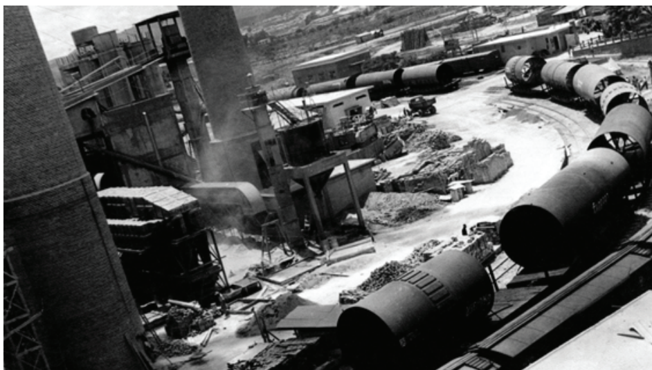
Companhia Cimento Portland Itaú em funcionamento. .
