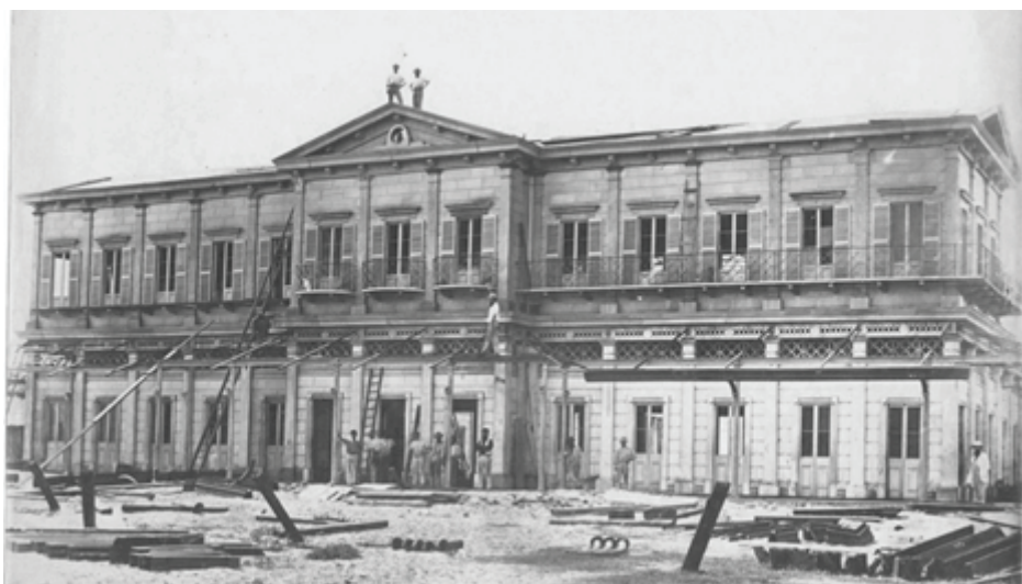
Fachada frontal da Estação de Jequitaia (Calçada).
