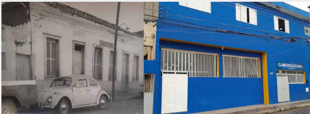
ESQUERDA: FACHADA DO CLUBE DOS CUTUBAS ANTES DA RESTAURAÇÃO, NA RUA 27 DE SETEMBRO, BEM NO CENTRO DE LEOPOLDINA (MG). DIREITA: PRÉDIO DO CLUBE RESTAURADO. CRÉDITO: ACERVO PESSOAL
