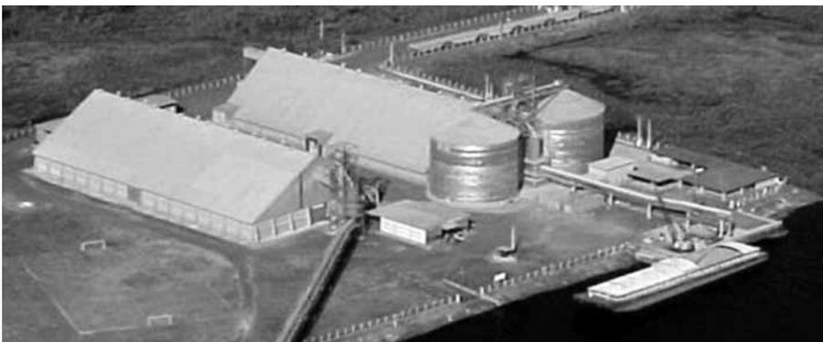
desvio ferroviário com pátio para 60 vagões, duas moegas rodoferroviárias e uma moega fluvial, dois berços de atracação, área de armazenagem externa de 20.000 m<sup>2</sup>. Em julho de 2004 foram construídos seis tanques para produtos químicos totalizando 8.000 m<sup>3</sup>.
