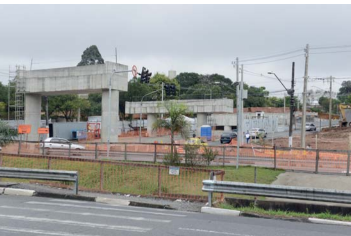
Um dos 12 corredores de ônibus (obra leste-oeste).
