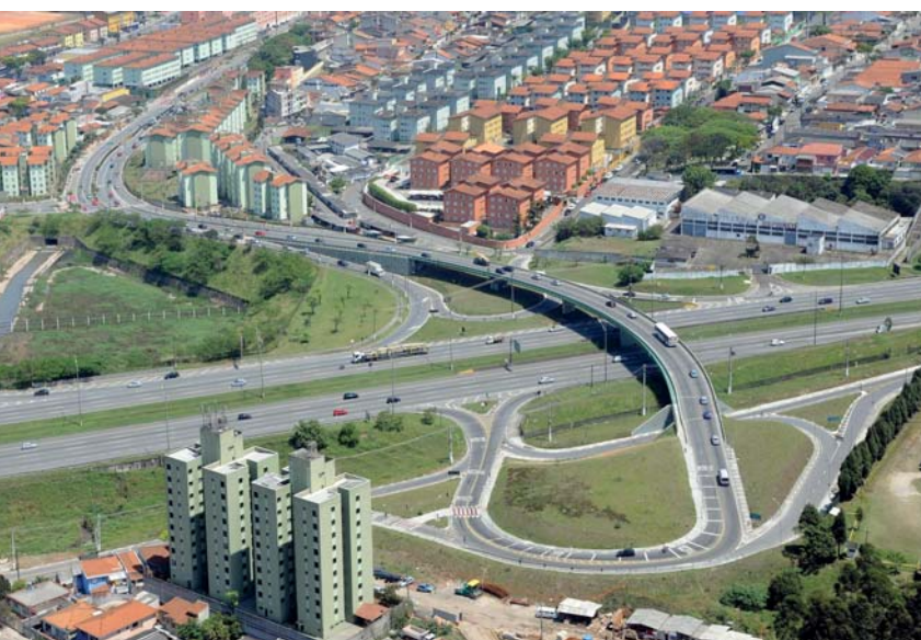
Viaduto Moiseys Cheid, concluído após 30 anos de abandono.
